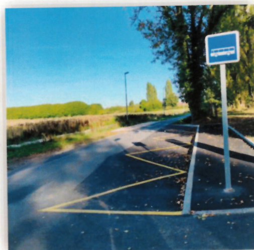
Arrêt de bus, Rue de la Tannerie.
